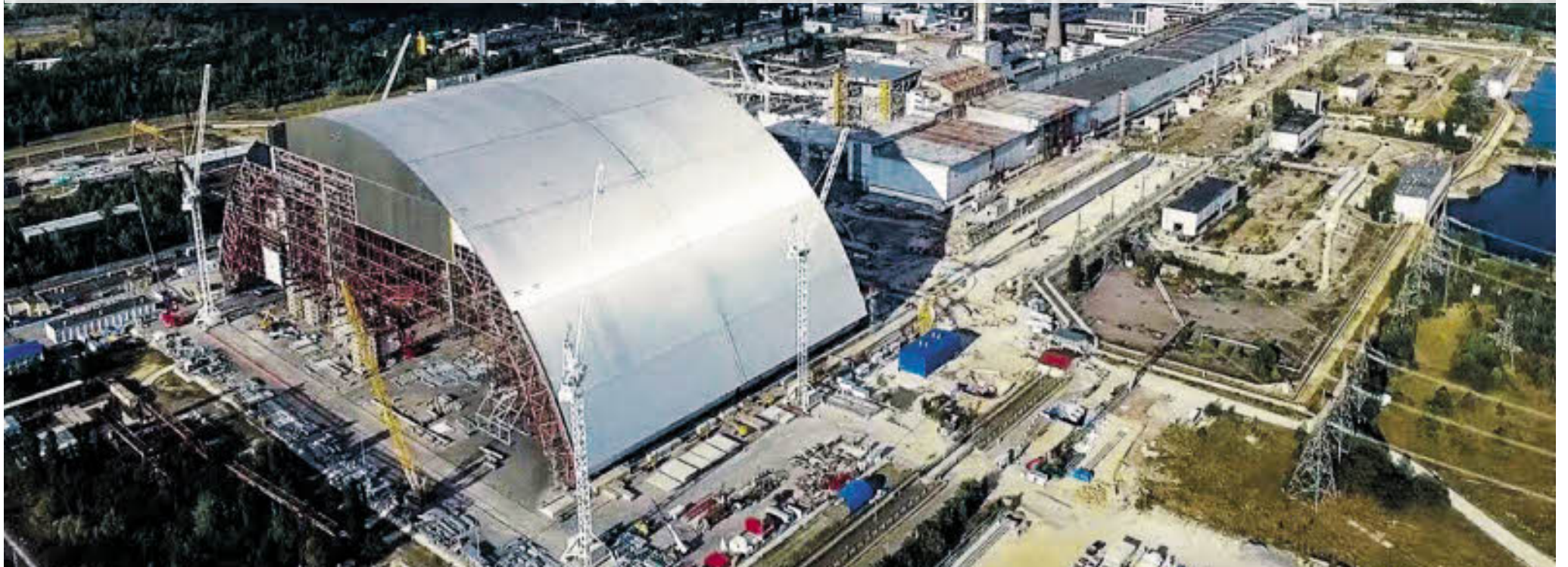
Vordergrund: Neue Schutzhülle, die über den havarierten Tschernobyl-Reaktor (Hintergrund) geschoben wird. Geschätzte Baukosten: 2,15 Mrd. Euro.
