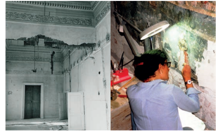
Zustand der Landkartengalerie vor und während der Restaurierung ©UBS
